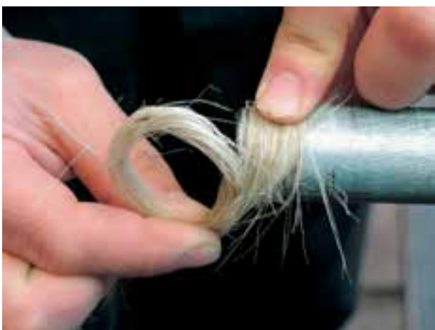
شکل ۱۳۸-۵- پیچیدن مواد آب‌بندی به سردنده‌ها
