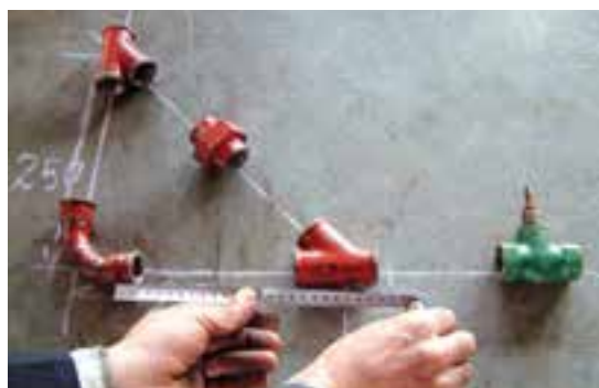
شکل ۱۳۴-۵- اندازه‌گیری لوله‌های مورد نیاز
