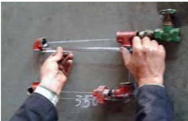
شکل ۱۴۹-۵- اندازه گیری طول لوله ها
