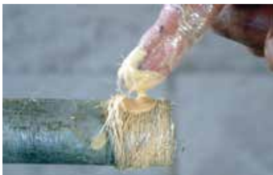
شکل ۱۵۲-۵- خمیر و کنف کردن سردنده‌ها
