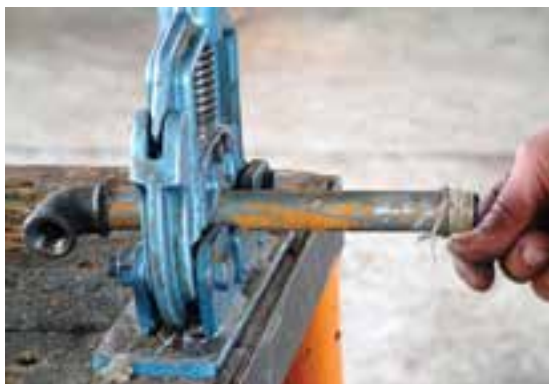
شکل ۱۵۳-۵- خمیر و کنف کردن سردنده‌ی بعدی
