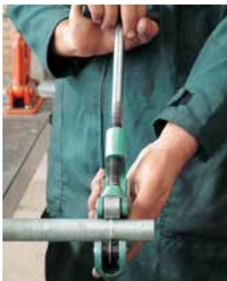
شکل ۱۳۵-۵- بریدن لوله‌های مورد نیاز
