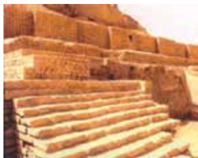
پلکان‌های ورودی در چهار ضلع معبد برای ورود به طبقه‌ی اول
