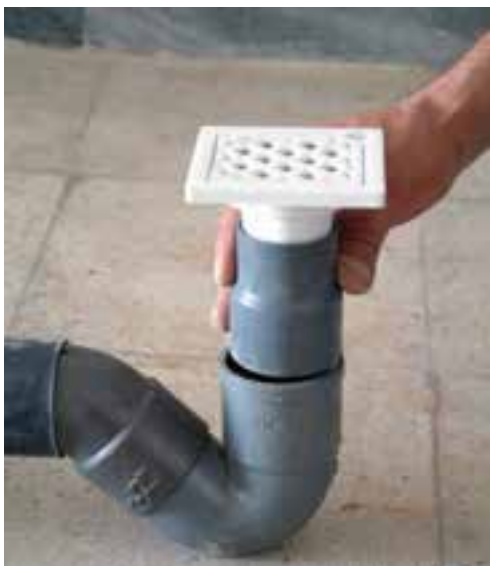
شکل ۳-۱۹- اتصال کف‌شوی به وسیله‌ی تبدیل
