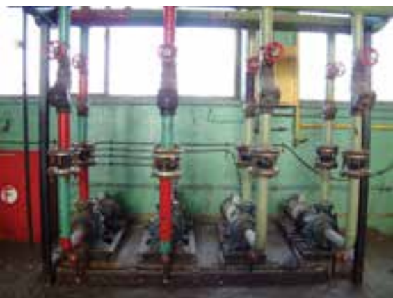
شکل ۳-۵- کاربرد لوله درزدار در لوله‌کشی شوفاز
