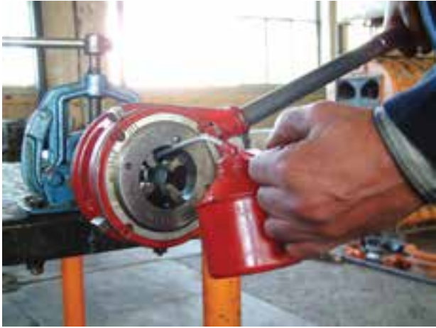
شکل ۴-۱۲۳- استفاده از روغن‌دان در جریان حدیده‌کاری
