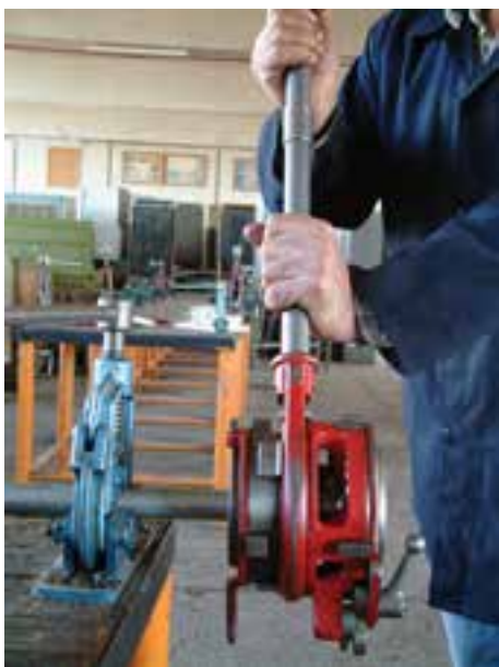
شکل ۱۲۶-۴- باز کردن حدیده از لوله
