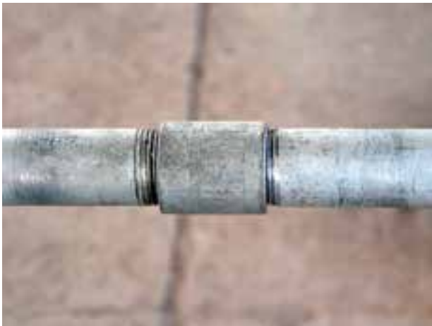
شکل ۳-۵- اتصال دنده‌ای
