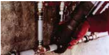
شکل ۲۳-۵ - اتصال پرسی
