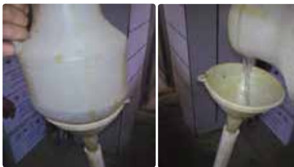
شکل ۱۸-۵- شست‌وشوی مبدل بعد از رسوب‌زدایی
