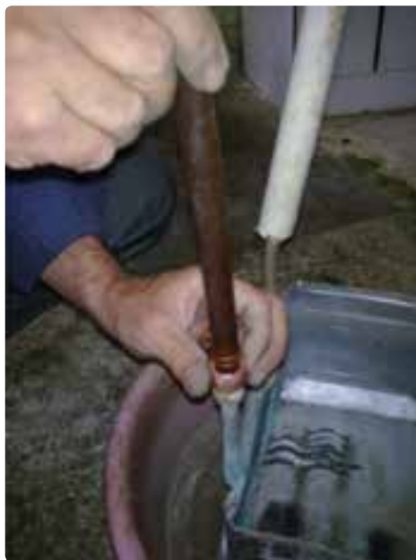
شکل ۱۶-۵- به یک طرف مبدل شیلنگ لاستیکی و طرف دیگر لوله پلاستیکی نوع PP متصل می‌شود.
