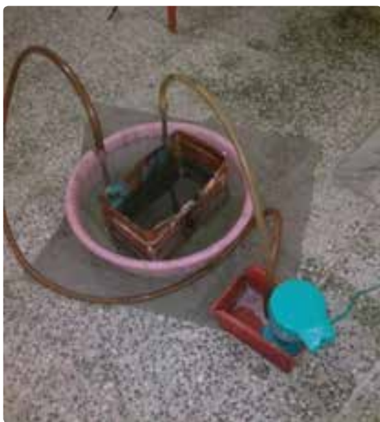
شکل ۱۹-۵- رسوب‌زدایی با پمپ
