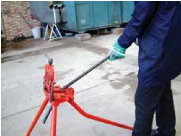
شکل ۳-۹- خم کاری لوله به وسیله‌ی گیره‌ی صحرایی
