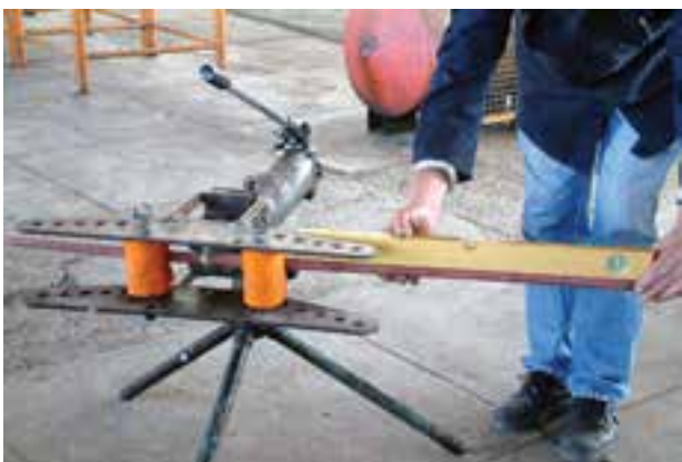
شکل ۳-۴۳- کنترل افقی بودن لوله در خم کاری
