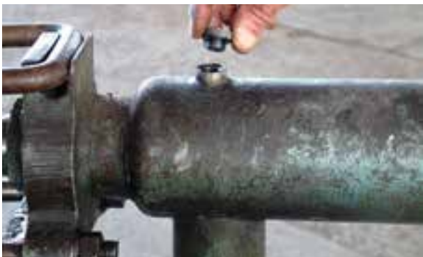
شکل ۳-۴۹- باز کردن سربوش و بازدید روغن داخل سیلندر
