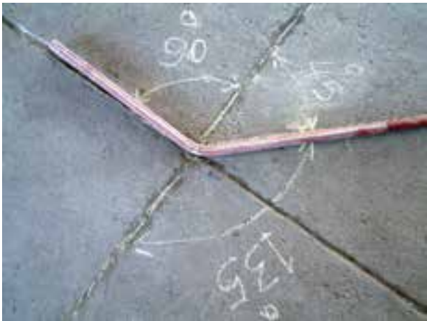
شکل ۲۹-۳- کنترل خم لوله های ۴۵ درجه
