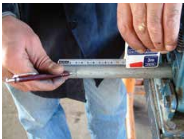
شکل ۱-۷- علامت‌گذاری کردن لوله با متر و مداد
