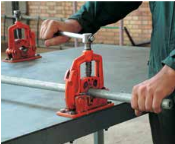
شکل ۱-۲۸- بستن لوله به گیره‌ی لوله
