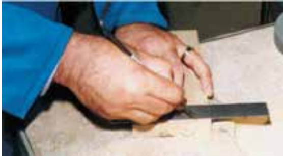
شکل ۶-۸۶- خط کشی با استفاده از گونیا.
