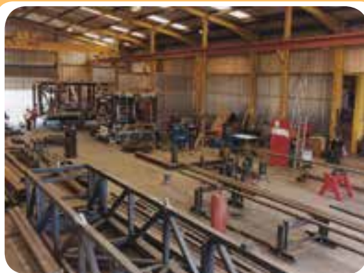
الف) کارگاه ساخت سازه‌های ساختمانی
