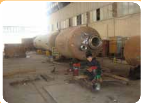
ب) کارگاه ساخت مخازن تحت فشار
