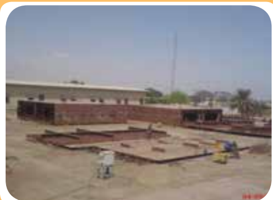
د) کارگاه ساخت اسکلت فلزی ساختمان
