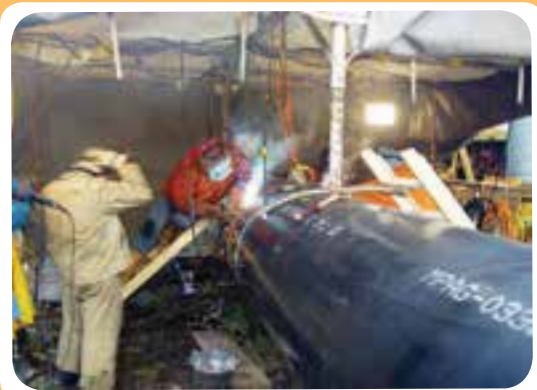
ن) کارگاه ساخت خط لوله
