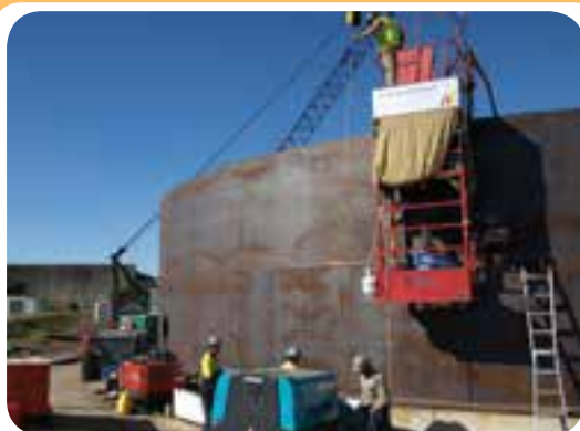
م) کارگاه ساخت مخازن ذخیره
