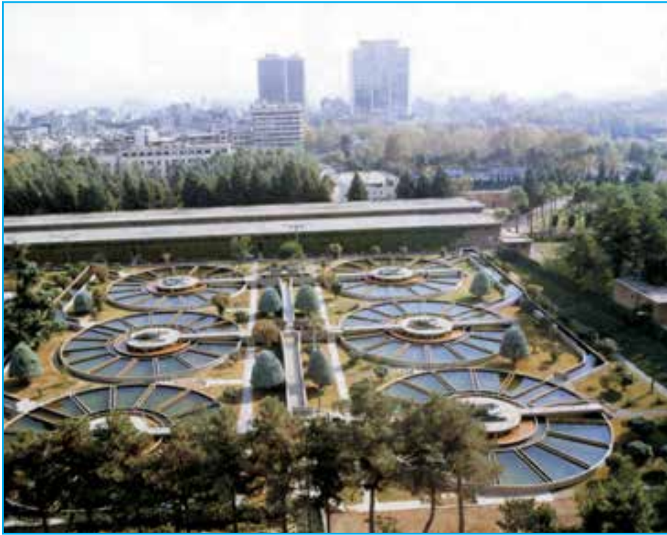
شکل ۱۴-۹- تصفیه خانه شماره ۲ آب تهران - جلالیه
