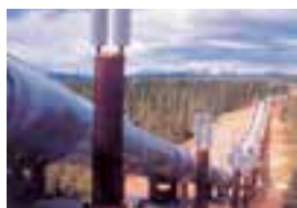
شکل ۱۱ محافظت لوله های نفت با میله هایی از جنس روی
