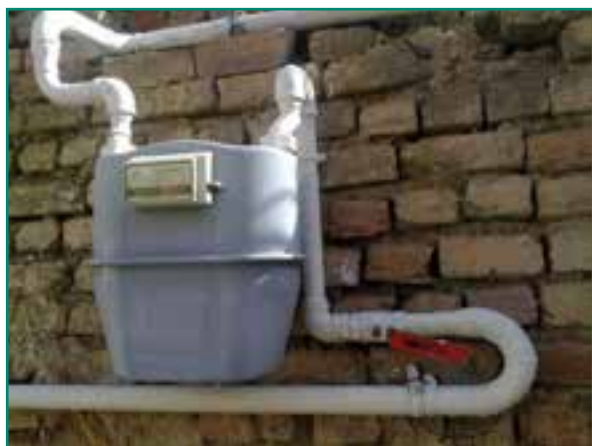
شکل ۸۱-۴ یک کنتور ۱۰ متری نصب شده
