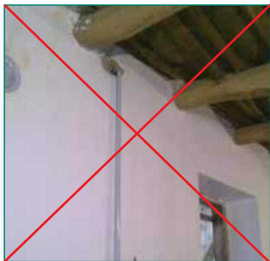
شکل ۴-۷ الف سقف نباید چوبی باشد
