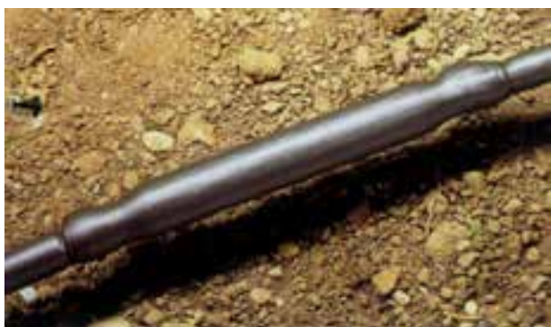
ج- وضعیت روکش پس از عملیات
