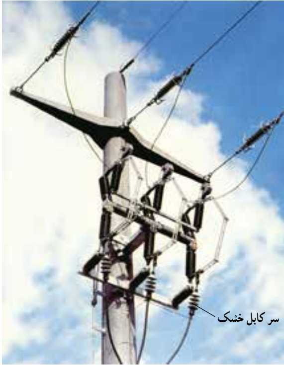
شکل ۶-۶- سر کابل خشک حرارتی هوایی
