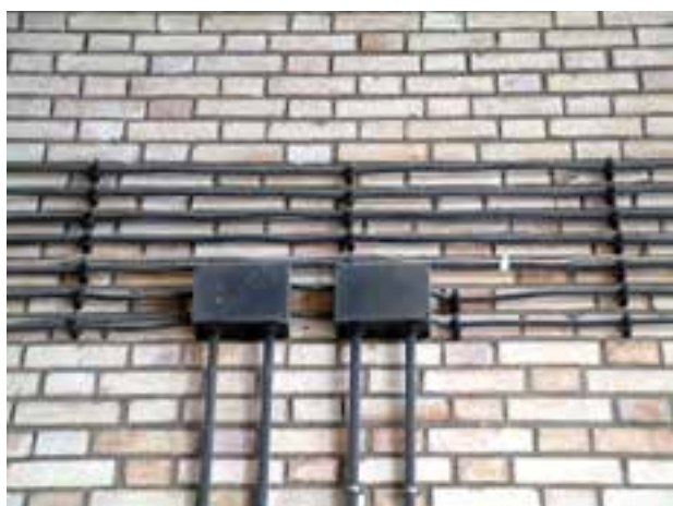
شکل ۵-۵۷- کابل‌کشی روی دیوار
