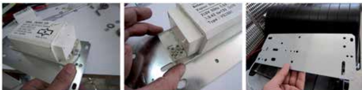
شکل ۲-۳۹ - نحوه نصب بالاست در نورافکن
