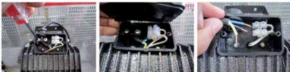
شکل ۲-۲۵ - سیم کشی در جعبه اتصالات
