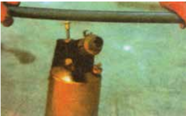
شکل ۴-۴۳- حرارت دادن لوله ی PVC
