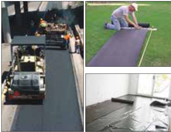
شکل ۴۴-۱ کاربرد قیر در آسفالت کاری و ایزوگام
