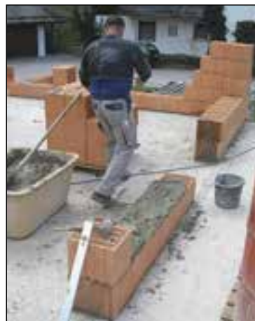
شکل ۱-۱۵۳ ساخت دیوار با بلوک سفالی
