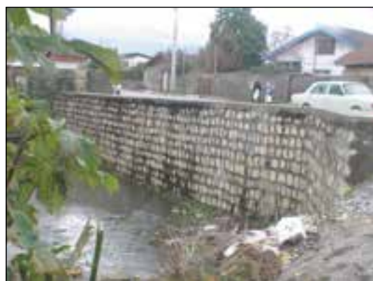
شکل ۱-۱۱۰ دیوار حائل سنگی
