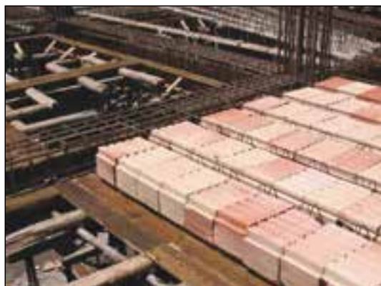
شکل ۱-۱۵۲ کاربرد بلوک سفالی در سقف
