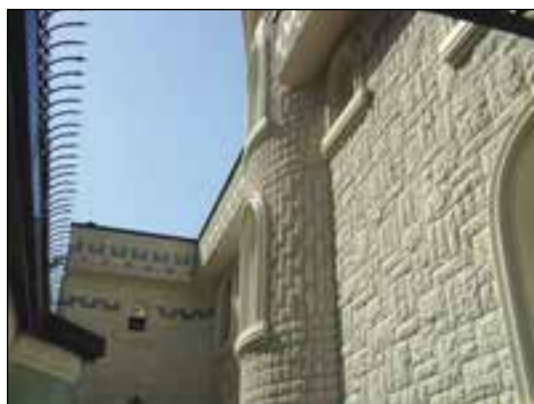
شکل ۱۳۱-۱ دیوار با مصالح سنگ بادبُر
