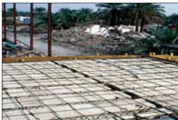
شکل ۱۳-۱ سقف تیرچه بلوک
