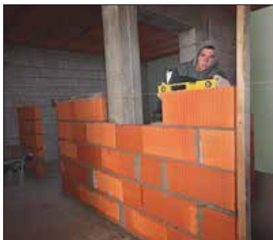
شکل ۱-۱۰۹ دیوار غیرباربر بلوک سفالی
