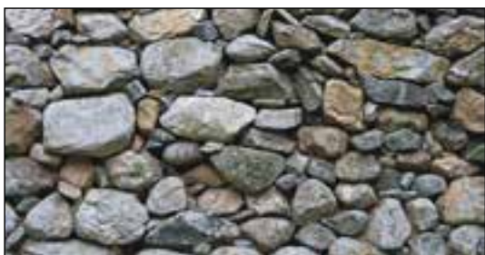
شکل ۱۳۶- دیوار سنگی خشکه چین
