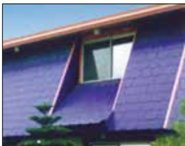
شکل ۴۷-۱ پوشش نهایی سقف شیب‌دار با آردواز
