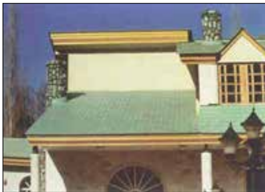
شکل ۱-۱۰۲ پوشش سقف با ورق‌های فشرده‌ی آردواز
