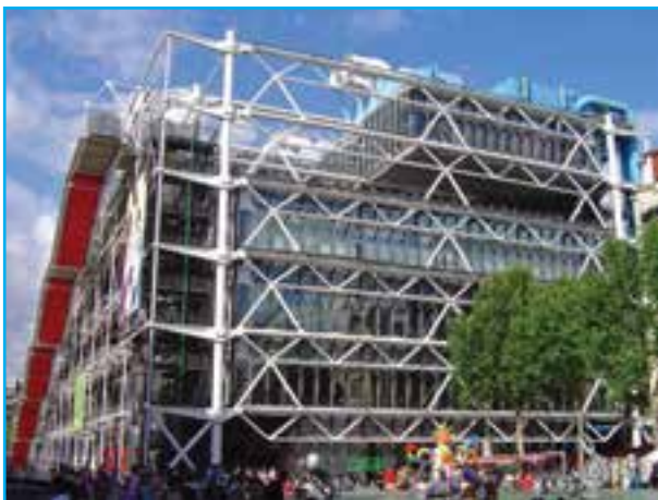
مرکز فرهنگی ژرژ پمپیدو در پاریس، تأکید بر سازه و تأسیسات در بنا، یعنی عامل اصلی مؤثر بر طراحی
