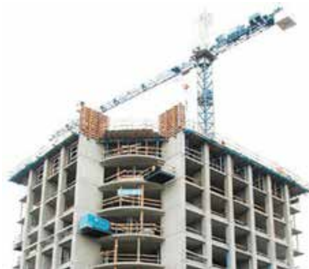
شکل ۱-۲- ساختمان با سازه اسکلت بتنی
