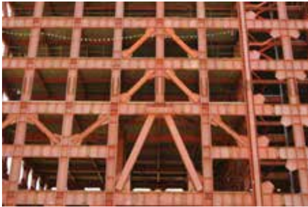
شکل ۱-۱- ساختمان با سازه اسکلت فولادی
