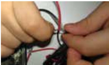
شکل ۳-۶- پیچیدن سیم ها به هم و عایق بندی آنها
