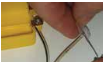
شکل ۲-۵- عایق‌بندی اتصال‌ها با نوارچسب شفاف
