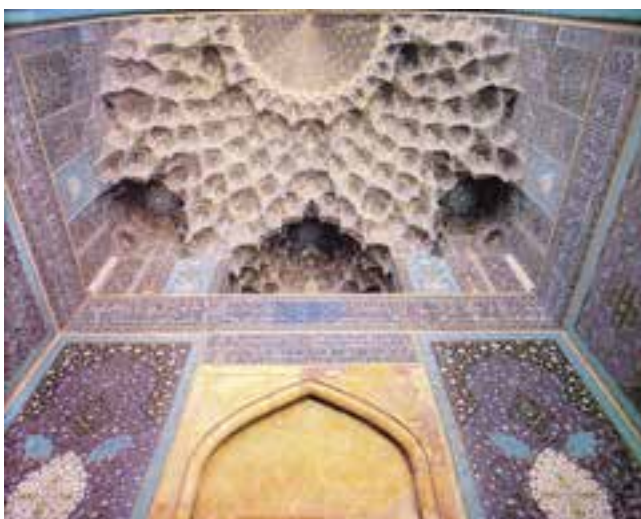
تصویر شماره ۵-۲۱ - سردر ورودی مسجد امام با پوششی از یک شبکه پر حجم مقرنس‌کاری
