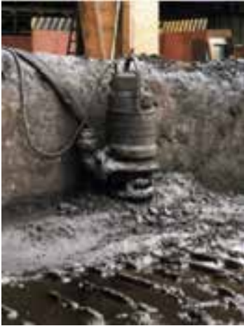
شکل ۹-۵- نصب پمپ کف کش در جاله
