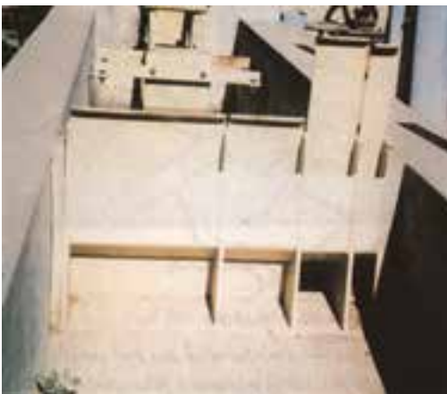
شکل ۹-۷- دریچه نیربیک
