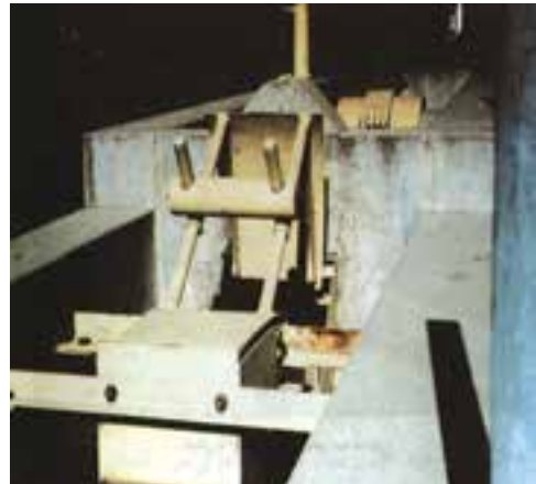
شکل ۸-۷- دریچه قطاعی و اتوماتیک
