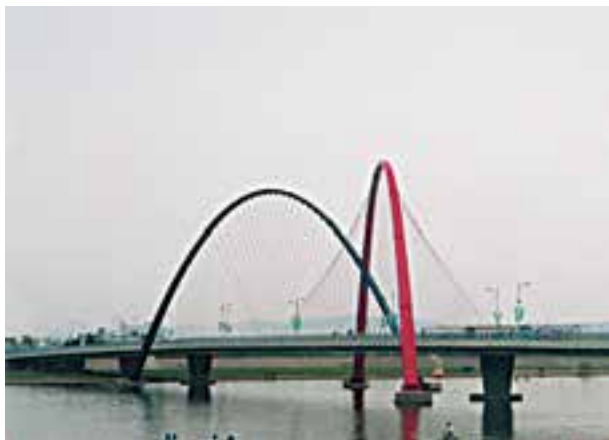
الف - پل معلق با دو قوس سازه‌ای بسیار زیبا با کابلهای کششی یک قوی آبی - یک قوی قرمز
