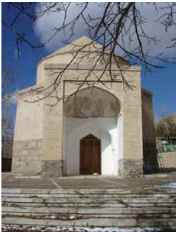
شکل ۱۲-۴- آرامگاه شاه‌قلندر از رهبران اسماعیلیه واقع در روستای انجدان اراک مربوط به دوره تیموری (مرمت آن در سال ۹۰۸ هـ. ق. دوره صفویه انجام شده)
