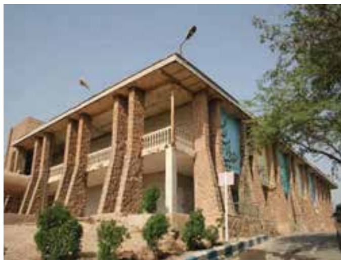
شکل ۳۰-۴. ساختمان گلف در اهواز
