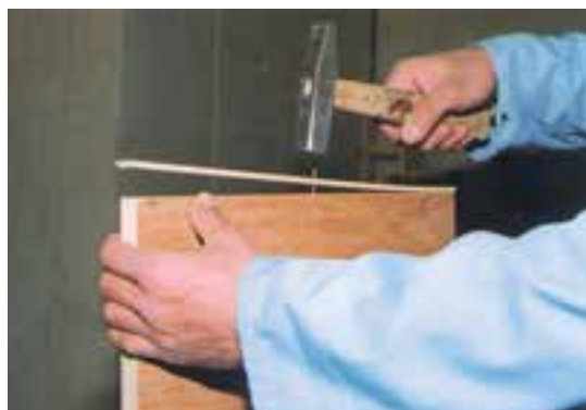
تصویر ۱۲-۶-۲- زهوارکوبی دور لبه زیرساخت
