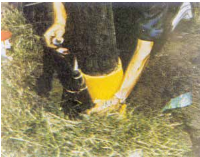
شکل ۱۱-۶- روش بانداژ کردن برای تیرهای نصب‌شده کهنه
