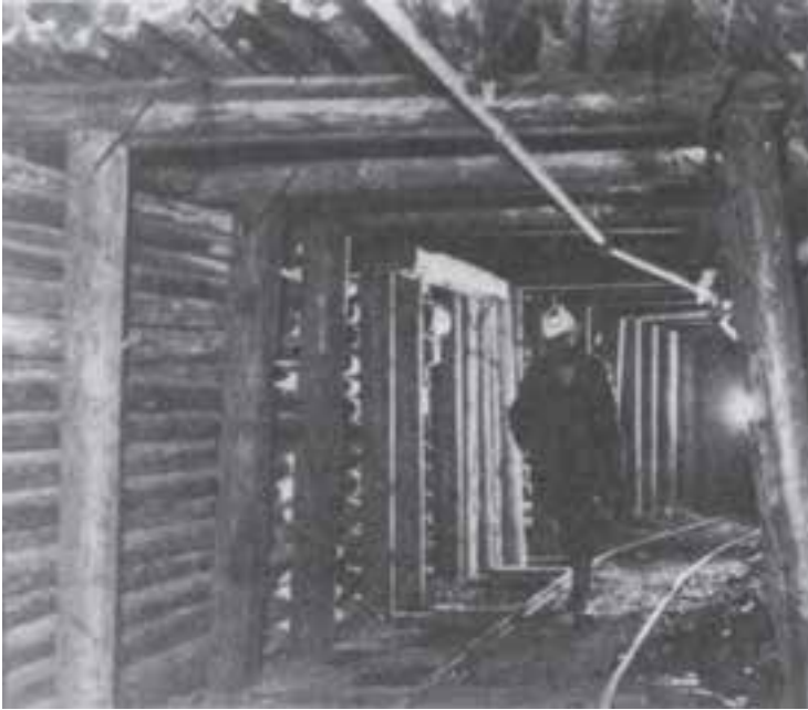
شکل ۲-۶- تیرهای تونلی اشباع شده با مواد حفاظتی روغنی
