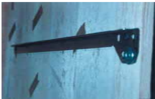
شکل ۳۱- نصب ریل روی بدنه
