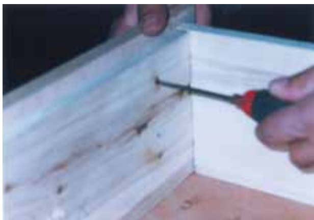
شکل ۳۲- نصب در بیرونی بر روی در داخلی (کاذب) به وسیله‌ی پیچ
