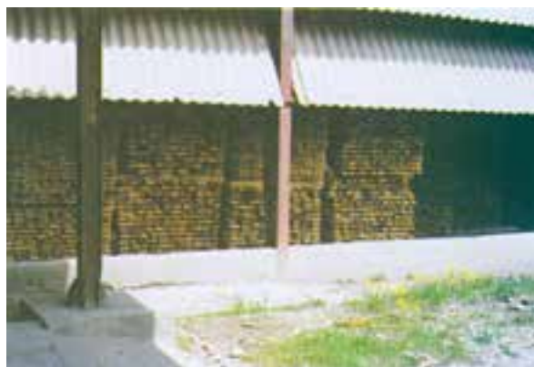
شکل ۲-۱۷- نحوه نصب آفتابگیر در اطراف واحد دسته‌بندی
