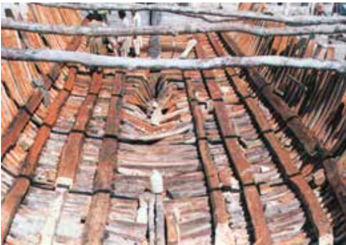
شکل ۱۳-۲- نصب تیرهای طولی روی فریم‌ها
