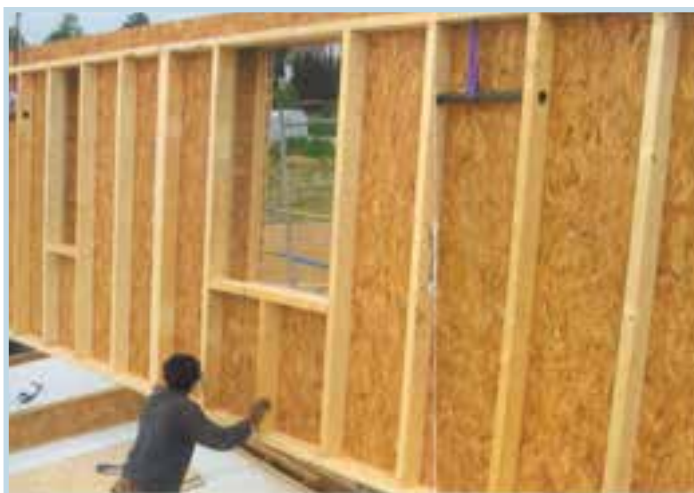
شکل ۴-۱- دیوار پیش ساخته چوبی در حین نصب
