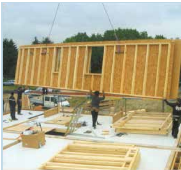
شکل ۳-۱- سوار کردن قطعات پیش ساخته در ساختمان
