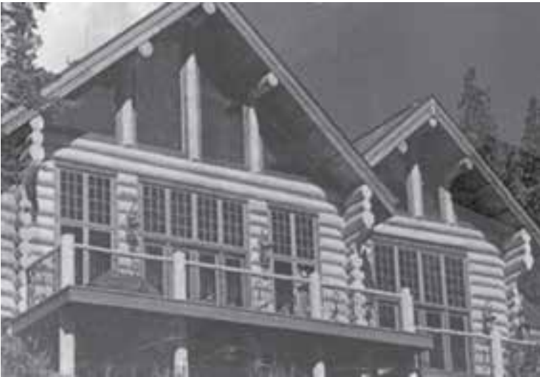
شکل ۱-۲۹- نمونه‌ای از ساختمان با چوب‌های گرد
