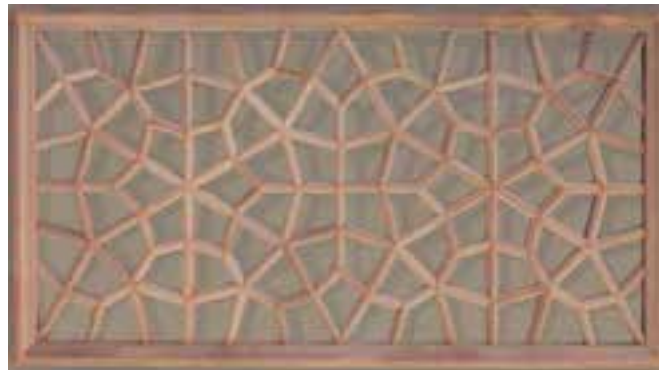
شکل ۹-۸۸- اتصال متقاطع در گره چینی یک پنجره.
