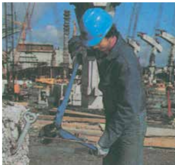
شکل ۱۲-۵۲- نحوه‌ی کاربرد سیم‌چین بزرگ
