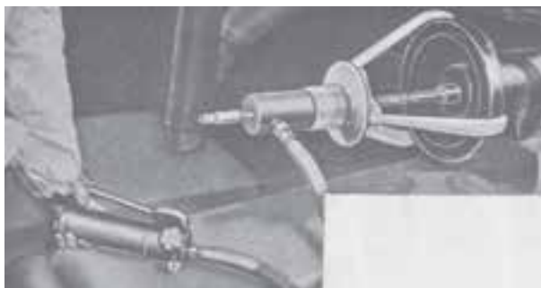
شکل ۱۲-۶۹- نحوه ی کاربرد پولی کش هیدرولیکی
