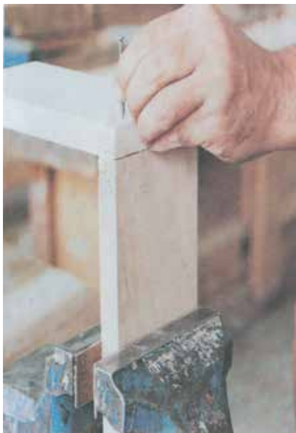
شکل ۱۱-۱۱- استقرار میخ
