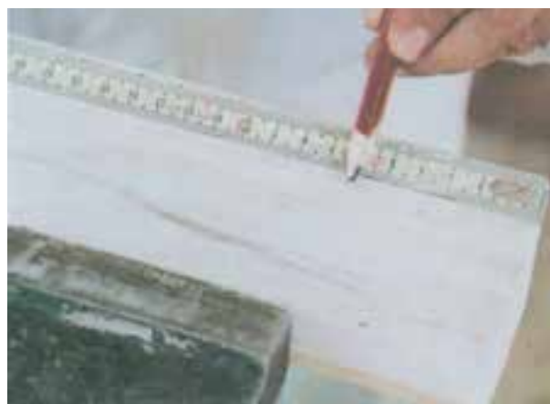
شکل ۷-۶ اندازه اتصال را روی چوب علامت‌گذاری کنید.
