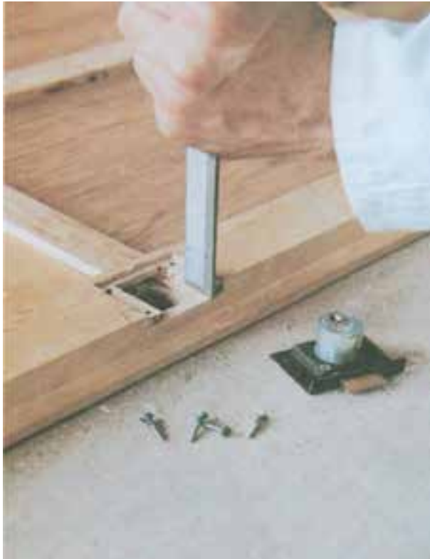
شکل ۱۵-۶ استفاده مغار برای در آوردن جای قفل
