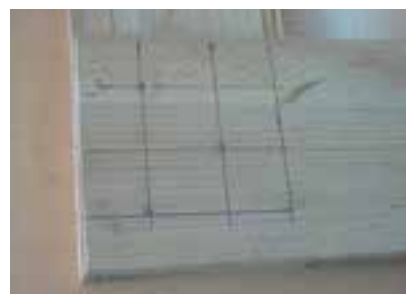
شکل ۵-۷۳- طریقه میخ‌کاری با فاصله مناسب
