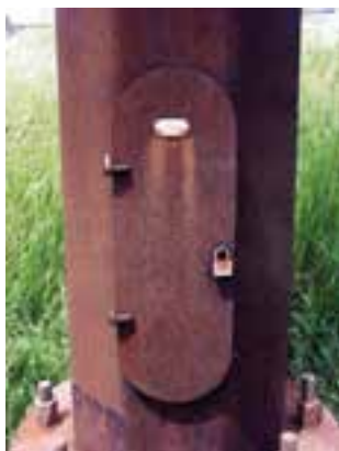
شکل ۷-۱۰- تشکیل پیل گالوانیک به دلیل نصب پلاک و قفل از جنس آلیاژ مس روی ستون فولاد کربنی
