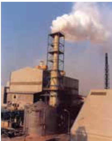
شکل ۲۶-۷- گازهای خروجی از دودکش در خوردگی تجهیزات اطراف واحد صنعتی مؤثر است.
