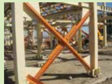
اجرای اتصال بادبندها از نوع پیچی
