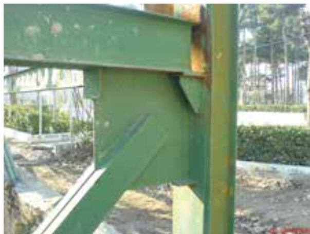
شکل ۳-۲- اتصال جوشی در سازه فلزی ساختمان
