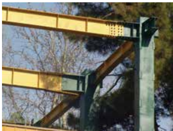
شکل ۳-۴- اتصال پیچی در سازه فلزی ساختمان
