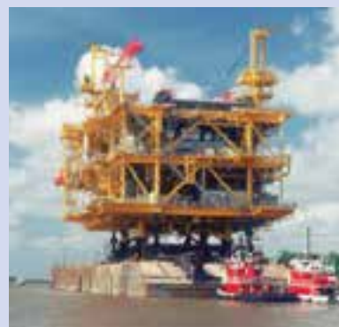
سازه فلزی یک سکوی حفاری که به محل پروژه حمل می‌شود
