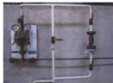
لوله کشی پست مرکزی گاز اکسیژن
