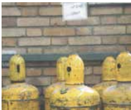
شکل ۳-۱۱ انبار کردن درست کپسول
