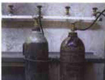
اتصال کپسول اکسیژن به خط لوله
