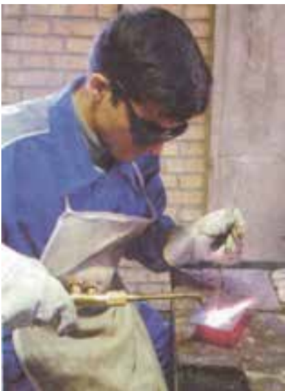
شکل ۸-۱۹ جوشکاری در حالت پیش‌دستی
