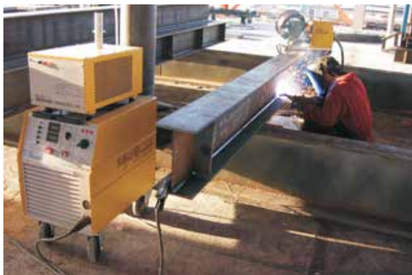
شکل ۱-۱۱-۲ جوشکاری با تورچ دستی MIG/MAG
