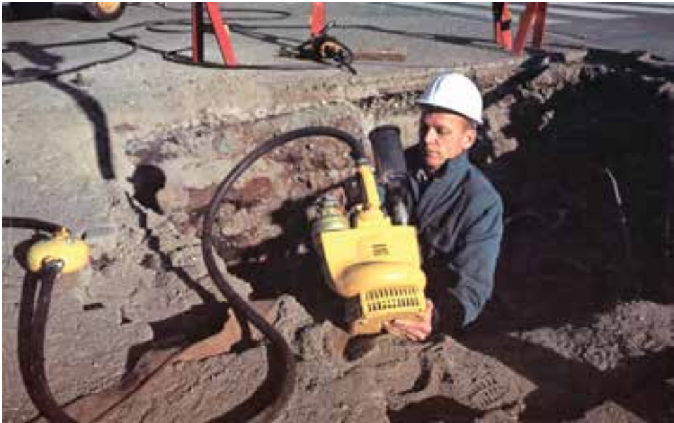
شکل ۱۸-۶- استفاده از پمپ با هوای فشرده
