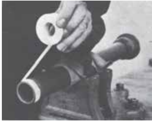
شکل ۲۷-۷- نوار تفلون و طریقه‌ی بستن آن به یک وصاله
