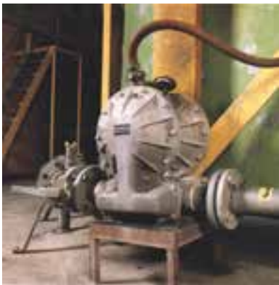
شکل ۲۵-۵- پمپ آب کشی با استفاده از هوای فشرده برای آب کشی موضعی
