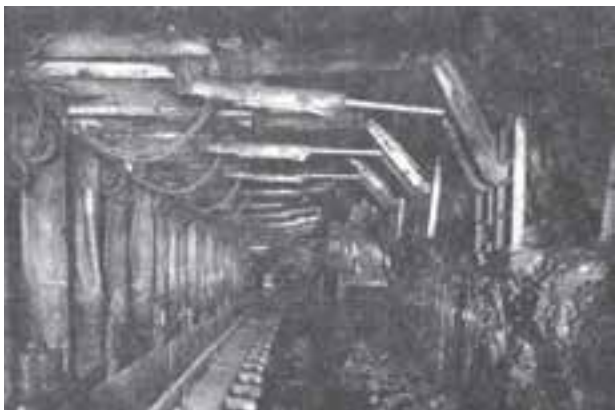
شکل ۴-۳۷- کاربرد ناو زنجیری در کارگاه استخراج
