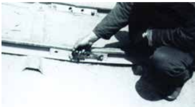
شکل ۵-۳۱ کارگر در حال بستن بغل‌بند
