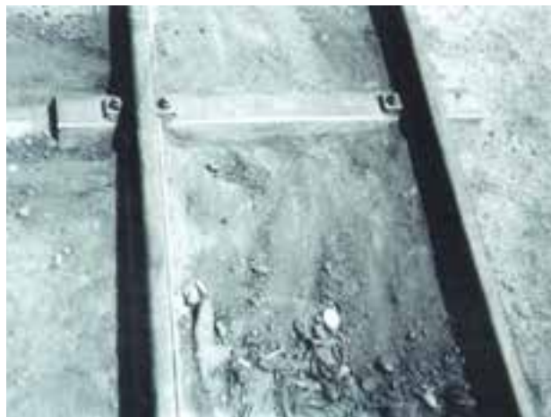
شکل ۴-۳۱ اتصال ریل به تراورس فلزی
