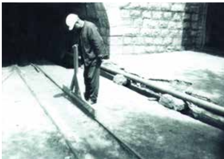
شکل ۸-۳۱- کارگر در حال اجرای روش واترپاس
