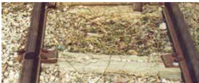
شکل ۳-۳۱- اتصال ریل به تراورس چوبی
