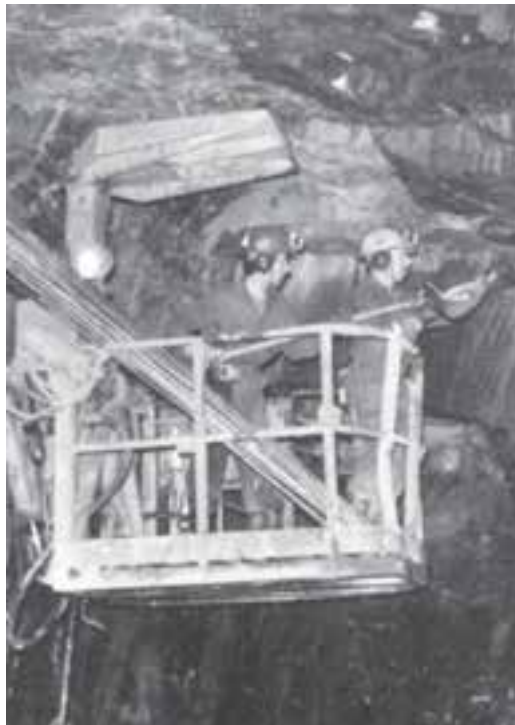
شکل ۲-۲۸- طریقه‌ی نصب پیچ سنگ
