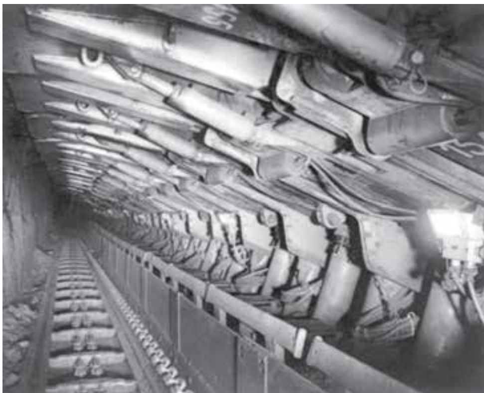
شکل ۱۳-۱- کاربرد ناو زنجیری در کارگاه استخراج
