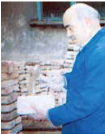
شکستن آجر به روش غلط
