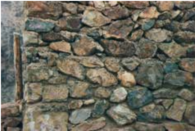
شکل ۶-۲- نمایش دیوار لاشه چینی با ملات
