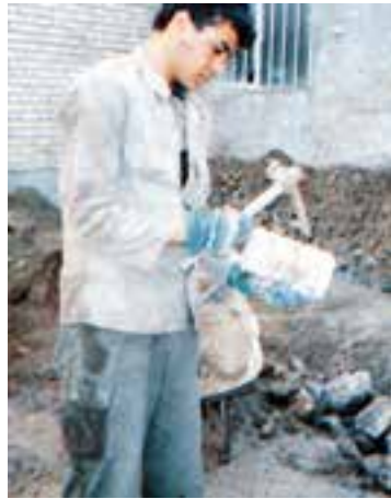
شکستن آجر به روش درست
