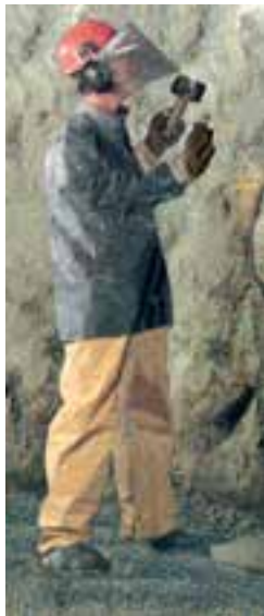
شکل ۵-۱۷- بازرسی سقف از طریق لرزش
