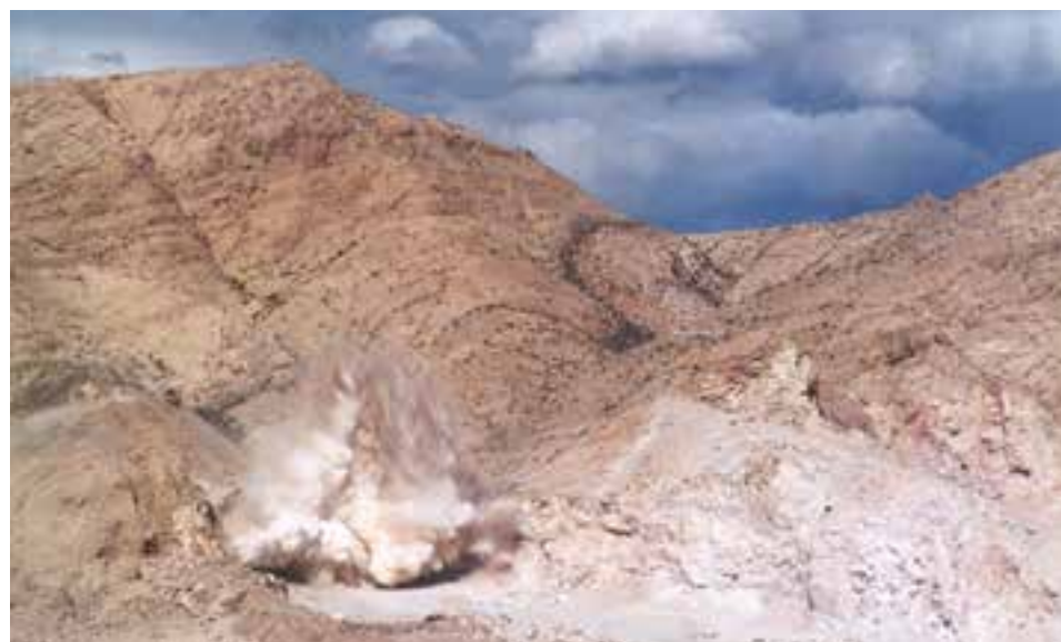
شکل ۲-۱۵-۱۶- مراحل شارژ چال و انفجار الف- فشنگ مسلح ب- مرحله‌ی شارژ چال ج- مرحله‌ی انفجار
