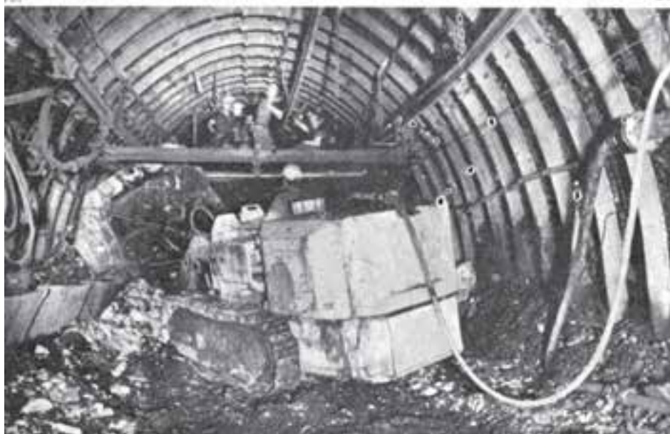
شکل ۱۰-۳ نحوه کار بارکننده در تونل
