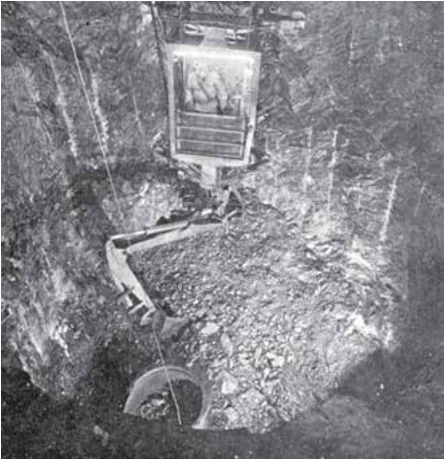
شکل ۱۰-۱۲- بارکننده قاشقی در چاه
