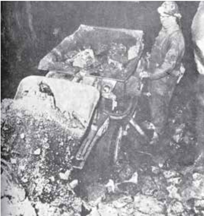
شکل ۱-۲- طرز کار بارکننده مکانیکی
